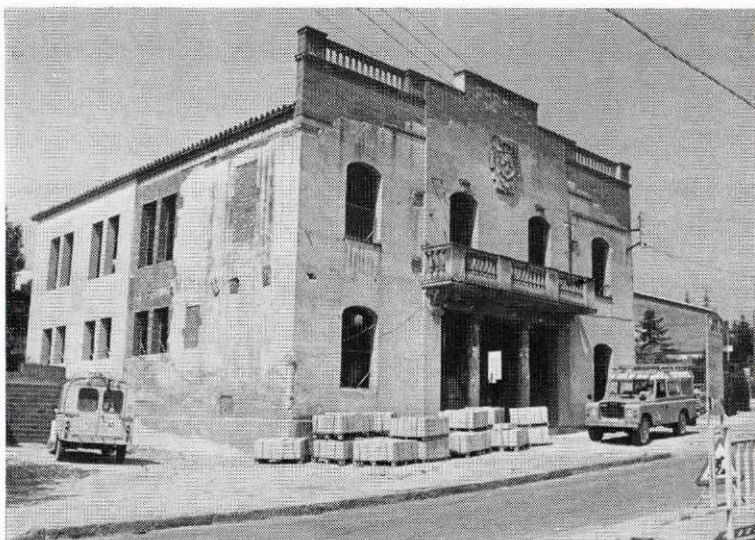
Reforma i ampliació de la Casa Consistorial.
