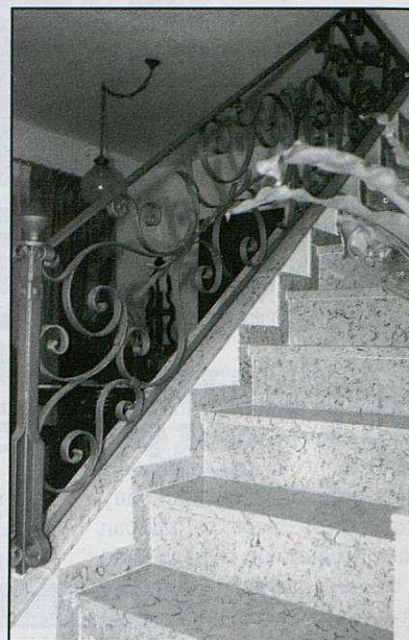
Barana interior forjada
