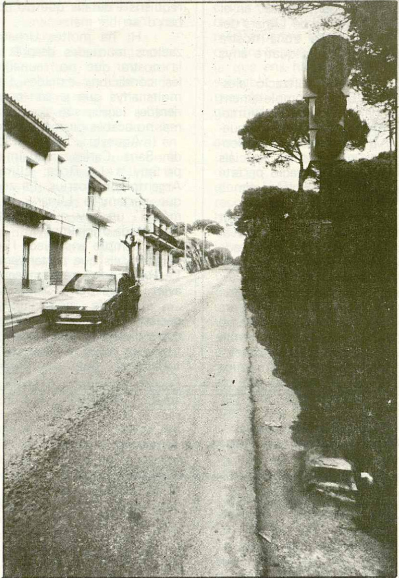
S'han instal·lat semàfors provisionals al carrer Anselm Clavé per poder regular el tràfec mentres durin les obres. Foto: AGUSTI
