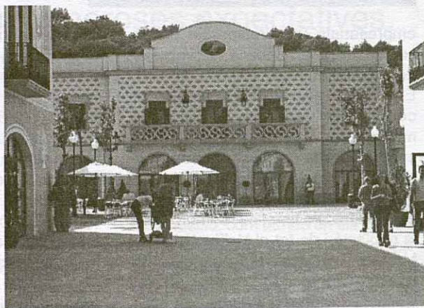
Vista des de l'entrada al recinte comercial.
