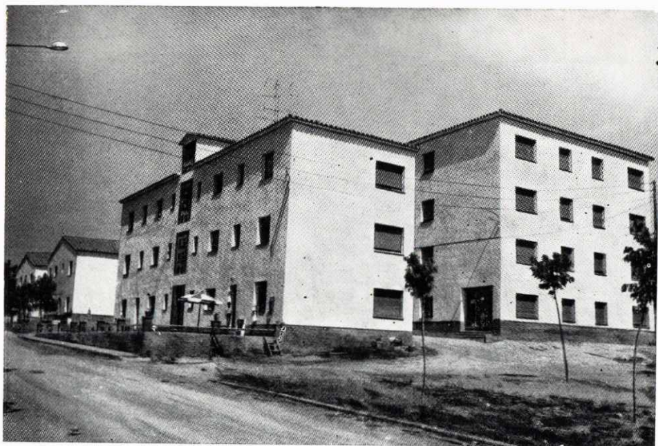
Bloques de viviendas construidos por el contratista D. José Gurri Ballús para D. Enrique Torras Gubern.
