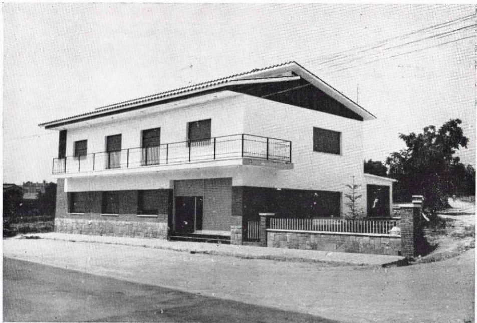
Casa construïda por D. Mateo Dantí Sala en la Carretera de Barcelona
