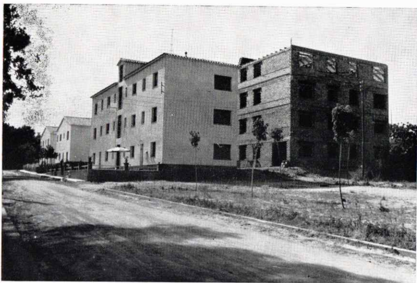
Bloques de viviendas construidos para el Sr. Enrique Torras en la calle Virgen del Remedio. Contratista: D. José Gurri Ballús
