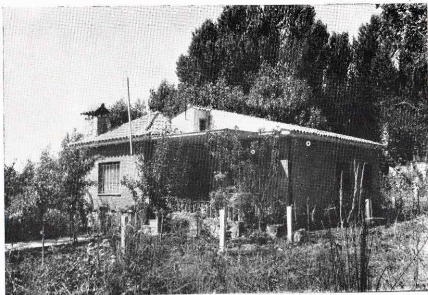
Casa construïda para D. José Cucurull Valle en urbanización «Can Sabater»
