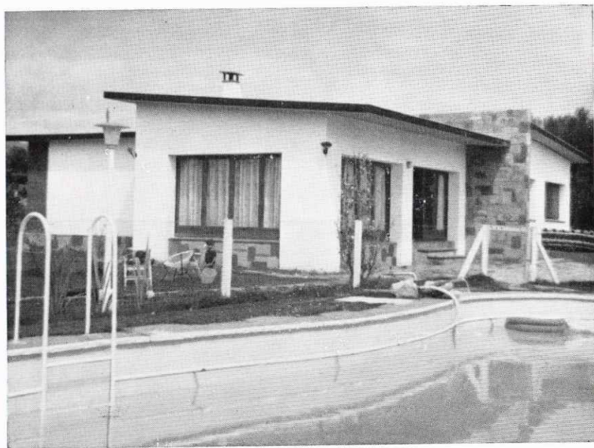
Chalet construïdo para D. Pablo Gómez Pulido, por el contratista D. Mateo Dantí.
