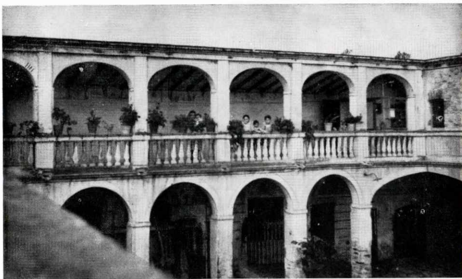
El terrat cobert
