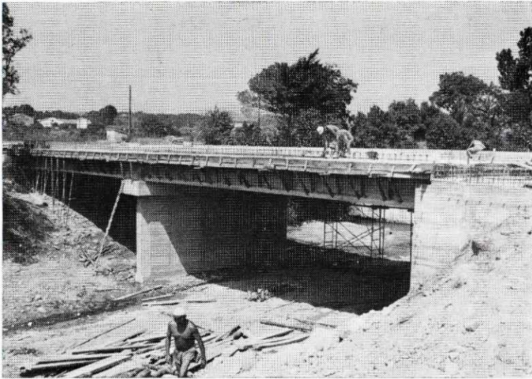
Construcció sobre el riu Tenes, del pont de Sant Cristòfol.
