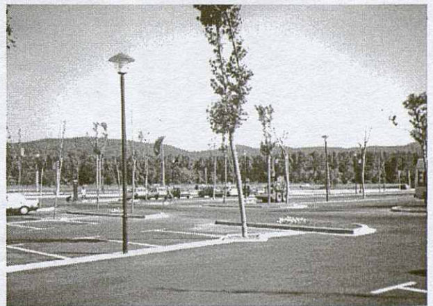
Vista de l'aparcament de la Ciutat Comercial.
