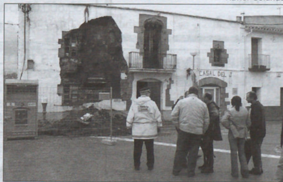
El estado ruinoso del antiguo Ayuntamiento sorprende a los vecinos.
