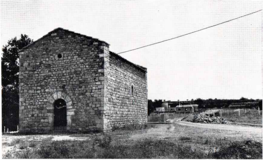
L'ermita de Sant Cristòfol després de la seva restauració. Les edificacions que neixen al seu voltant la treuen del seu secular aïllament
