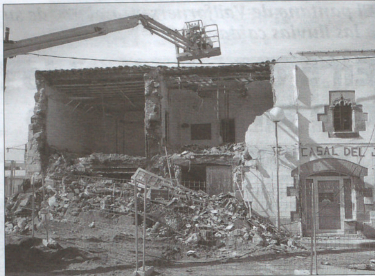
Las obras de derribo seguían el miércoles.
