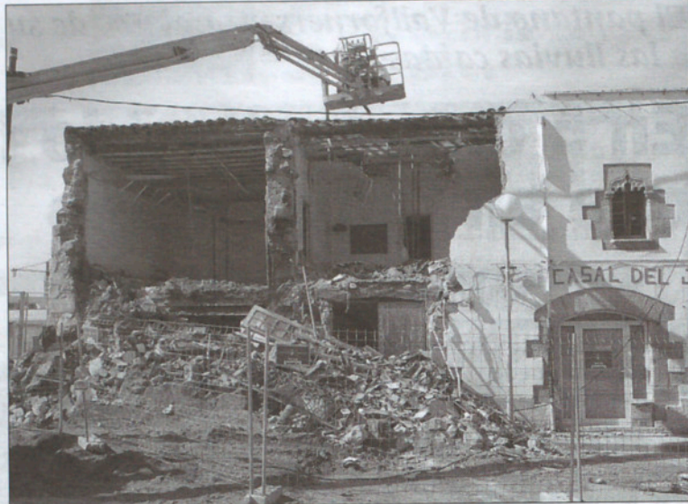
Las obras de derribo seguían el miércoles.
