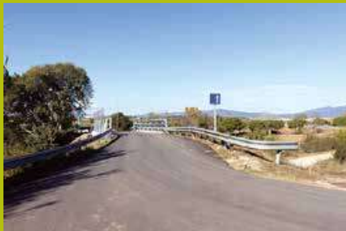
Obres de millora de l'accés al centre penitenciari de Quatre Camins
