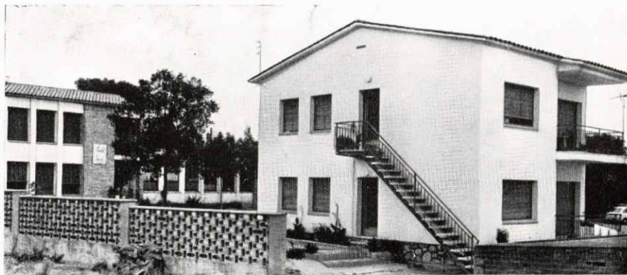
Nuevas viviendas para maestros en las Escuelas del Rieral.
