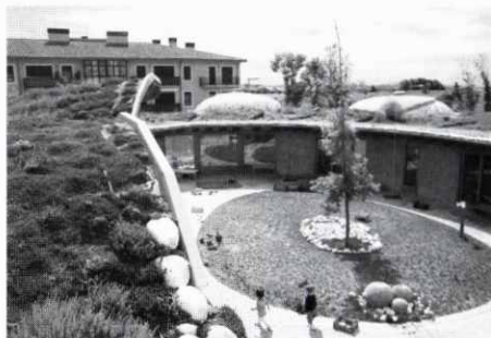
Escola Bressol La Font del Rieral.
