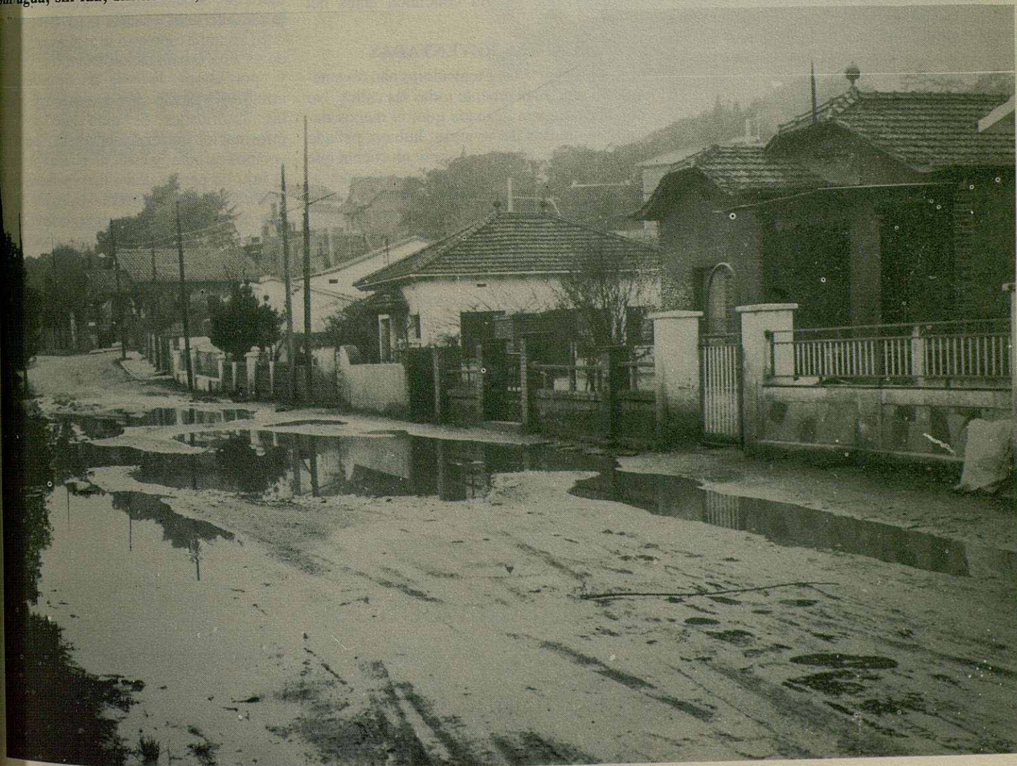
Sin agua, sin luz, sin asfalto, con demasiado barro...
