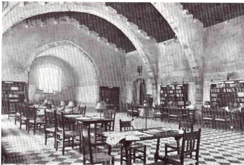
LA BIBLIOTECA.—Sala gòtica del que fou Hospital de Sant Domènec, magnífic estatge avui, de la Biblioteca pública de la ciutat.
