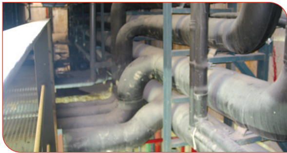
Connexió amb l'edifici industrial
