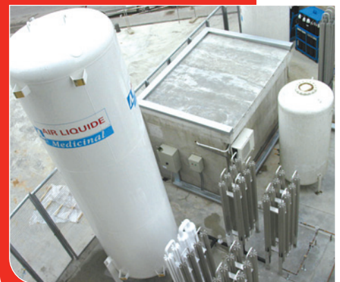
Nova instal·lació de gasos medicinals
